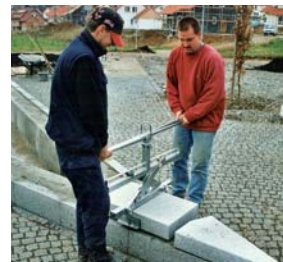
Kleště na betonové nášlapy TSV
