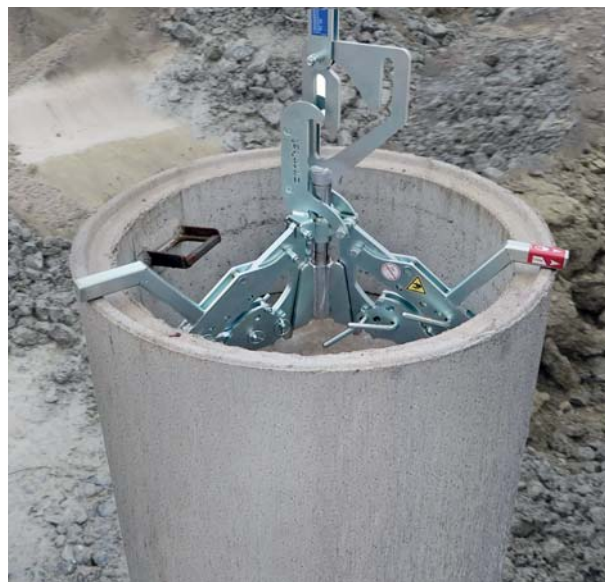
Kleště na kladení skruží a kónusů SVZ-UNI
