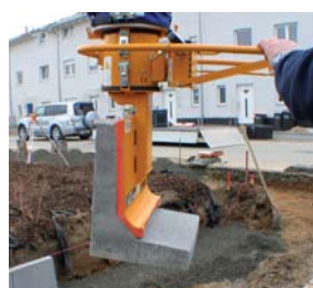
Speciální sací deska pro úhlové betonové výrobky
