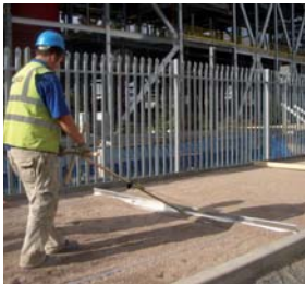
EASYPLAN EP-UNI system ręcznych łąt profilujących
