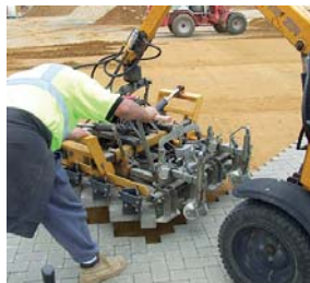
HVZ do układania kostki w „jodełkę” pod kątem 45 stopni
