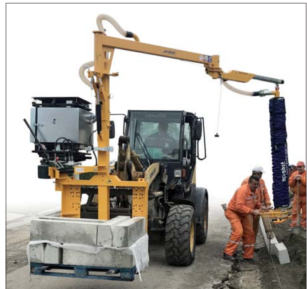
JUMBO-BV-VARIO Układarka do podciśnieniowego układania krawężników
