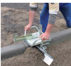
GUTTERFIX RF-H Przyrząd profilujący do krawężników
