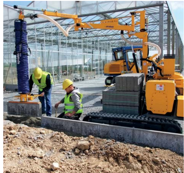
TRANSMOBIL TM Podciśnieniowa układarka do krawężników
