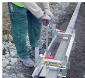
Szalunek do wykonywania oporu krawężnika GR-150
