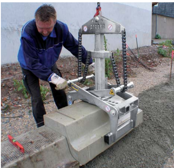
Chwytek do prefabrykatów betonowych FTZ-UNI-15
