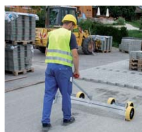
LEVELFIX LF-125/215 Ręczny system do niwelacji
