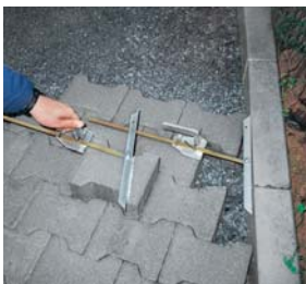
Przyrząd do odwzorowywania MAL
