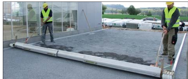
Łata teleskopowa do profilowania podłoża TAS-UNI
