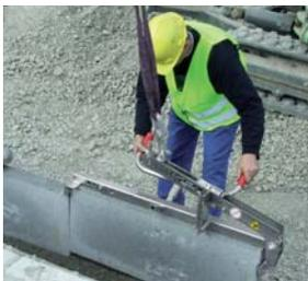
Pinza mecánica de colocación de bordillos VZ-M-UNI
