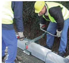
Pinza de colocación de bordillos BVZ
