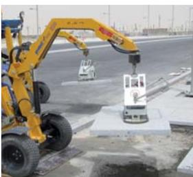
VACUUM-STONEMAGNET SM Equipo de incorporación por Vacío
