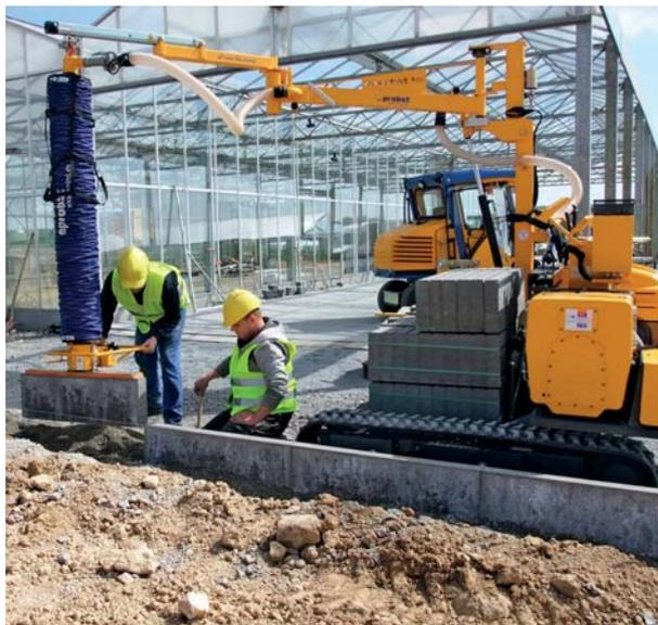
TRANSMOBIL TM Máquina colocadora y transporte de bordillos
