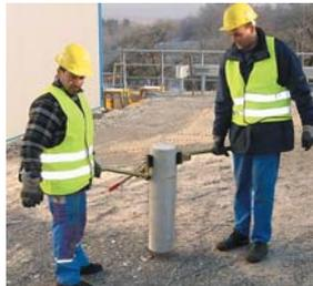
Pinza de colocación de palisadas PVZ
