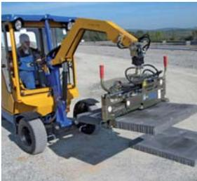
Pinza hidráulica colocadora de bordillos VZ-H-UNI
