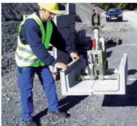
Pinza colocación canales cables KKV-200
