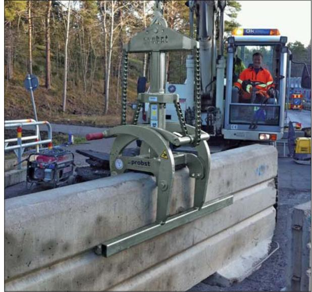
Pinza para prefabricados FTZ-GBA-S
