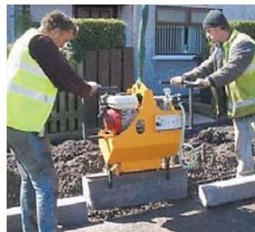
Equipo de incorporación por Vacío SH-1000-MINI-B
