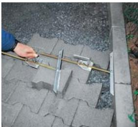
Calibrador para trazar MAL
