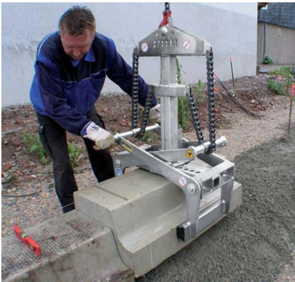
Pinza para prefabricados FTZ-UNI-15
