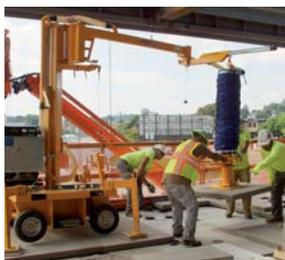
JUMBOMOBIL JM-VARIO Máquina Colocadora de Losetas por Vacío
